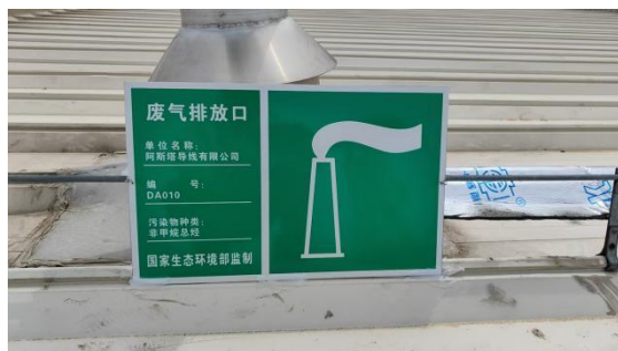
包漆、烘干废气 DA010 排口
