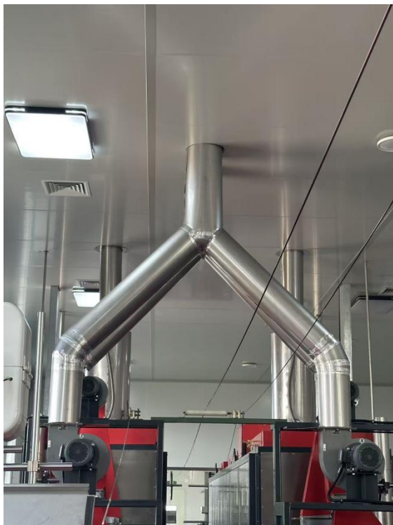
产品冷却废气收集装置
